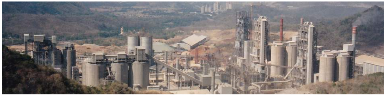
1996 年时，三套水泥生产系统均已次第安装完成。图示全厂之侧面鸟瞰照片。
