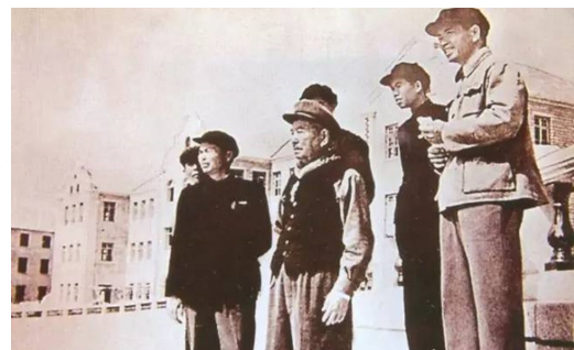
解放后，陈嘉庚（前）视察厦门大学建南楼工地
