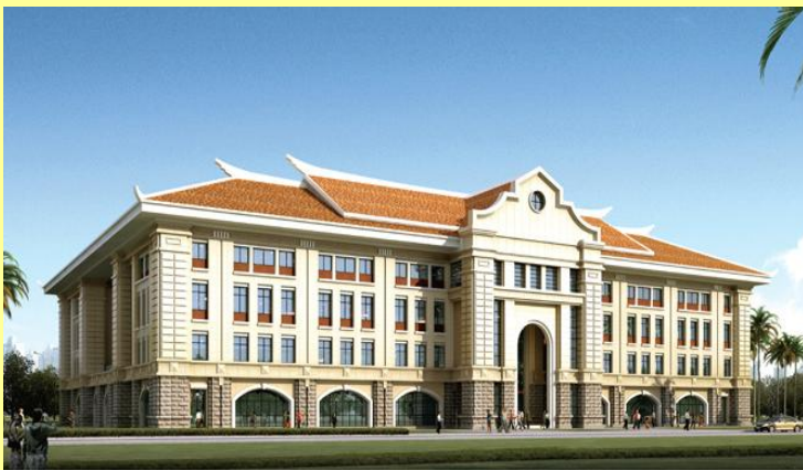
公共卫生学院大楼
