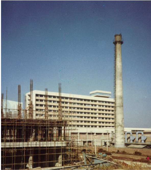
1984年10月时之天津水泥设计研究院8层主楼。 其前向仍在建筑中：右为锅炉排气烟囱
