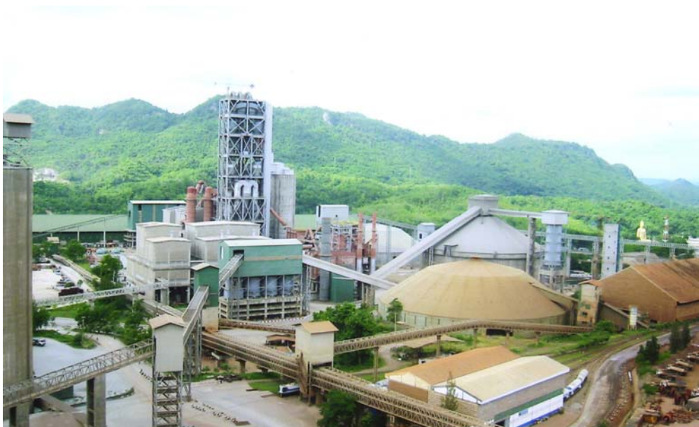
在泰石油宝麟公司(TPIPL)水泥厂第四套生产系统完成程度之鸟瞰 - 2005 年 6 月 20 日
